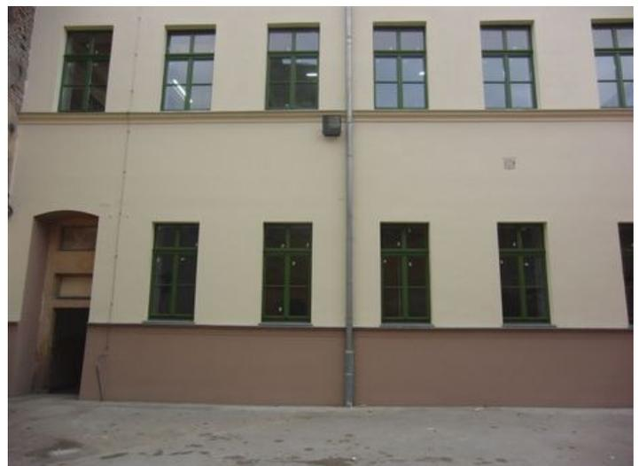
Neueindeckung des Dachs), die Entwässerung sowie die dem Sporthof zugewandte Fassade der Schule. Diese wurde thermisch isoliert, in den historischen Farben gelb und braun gestrichen und die neuen Fenster wurden eingesetzt. Im Innenhof wurden die Wände isoliert und verputzt, die Fenster aber noch nicht alle eingesetzt. Auf den Straßenseiten wurden die Arbeiten noch nicht begonnen. Im Frühjahr soll eine erneute Ausschreibung für die noch ausstehenden Arbeiten erfolgen.
